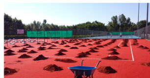
4 - Mise en place de la brique pilée.
